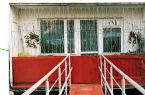
Im Stadtzentrum stehen die Balkone »Pesaro-Urbino« und »Halberstadt«. Foto: Beispielbalkon
